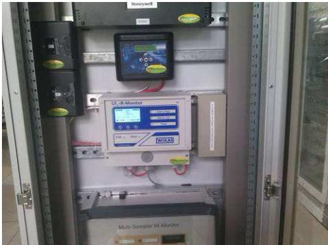
L'SF6 è un gas utilizzato come isolante negli interruttori di media e alta tensione e nei trasformatori di misura (TA e TV) d'alta tensione. L'uso dell'SF6 come mezzo isolante e di estinzione dell'arco è alla base dello sviluppo delle apparecchiature di manovra e protezione in AT e MT degli ultimi 50 anni. Dal 1978, con ENEL, ha inizio l'omologazione di tali apparecchiature, coprendo dal 1988 anche la tecnologia dei trasformatori di corrente in SF6.
