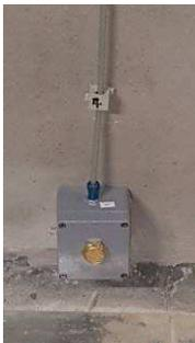
Il quadro rivelazione gas SF6 e antincendio installato presso la stazione elettrica Terna di Casuzze è dotato di etichetta QR per la consultazione di documenti, database e manuali, grazie a cui installatori e manutentori futuri avranno supporto in caso di guasti o malfunzionamenti. In tal modo inoltre la documentazione, altrimenti cartacea, è conservata in formato elettronico ed è rapidamente accessibile e aggiornabile.
