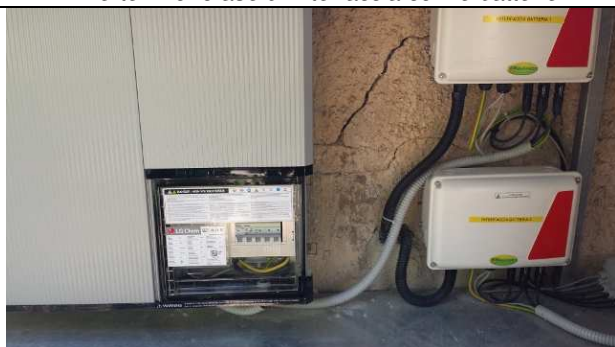
Particolare batteria di accumulo con sezionatore integrato
