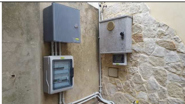
Contatore di scambio e contatore di produzione
